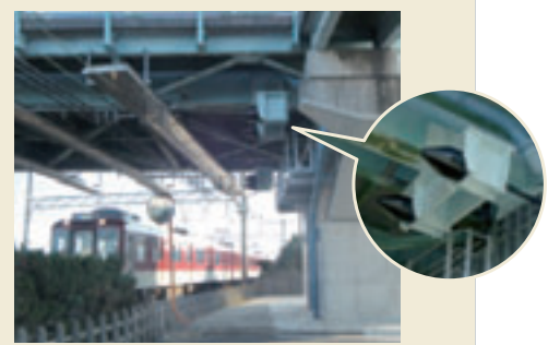
落橋防止装置を取り付け耐震化 (馳出町)
