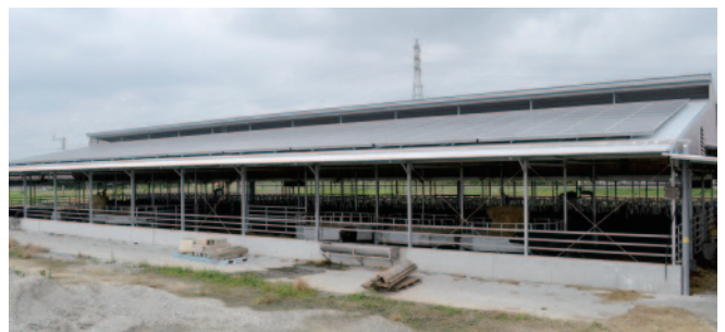
太陽光発電設備を設置した牛舎
