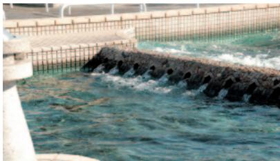
稲葉翁記念公園には、潮吹き防波堤の仕組みが分かるレプリカがあります。ボタンを押すと、波が起きて、防波堤の穴から潮を吹き出し、波消しをする仕組みを確認できます。ぜひ試してみてください。
