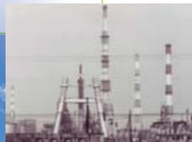
建設中の高煙突
