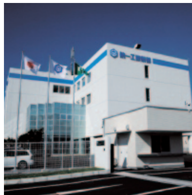
竣工した第一工業製薬(株)四日市事業所霞工場
