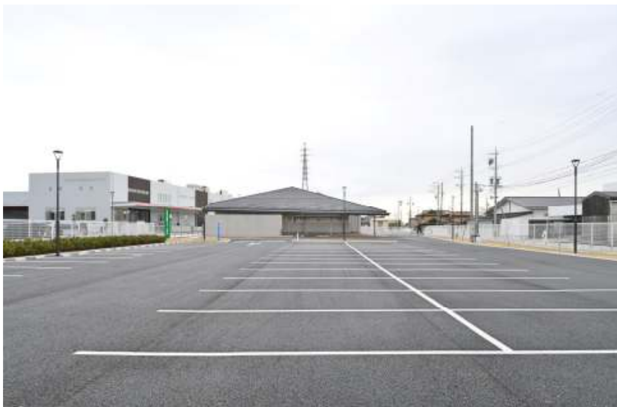
事務所棟 駐車場 ※透水性アスファルト舗装
