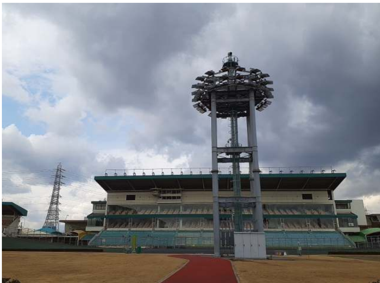
照明鉄塔 照明器具(LED)
