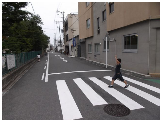
路面表示（施工後）
