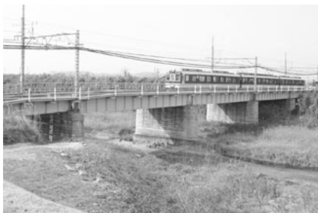
鈴鹿川派川の近鉄橋梁
