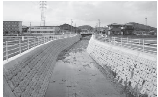
改修整備を進めている米洗川
