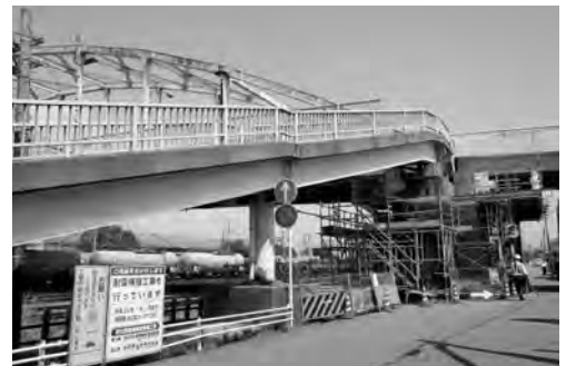
耐震補強工事を行っている馳出跨線橋
