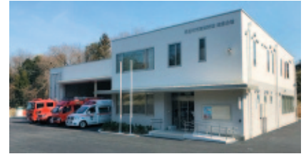
南消防署南部分署
