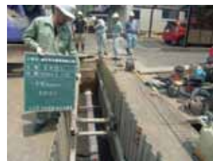
下水管の延伸工事
