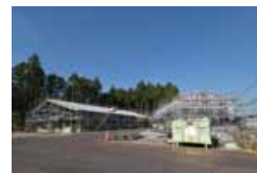
建設中の茶業振興センター(平成29年10月現在)
