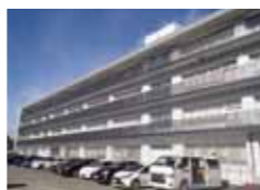
改築した笹川中学校
