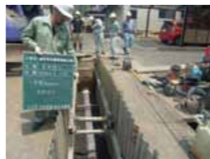
下水管の延伸工事
