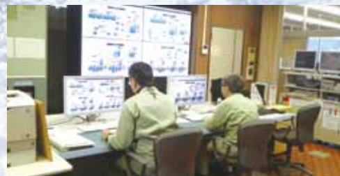
水源施設に異常がないか、24時間体制で監視しています
