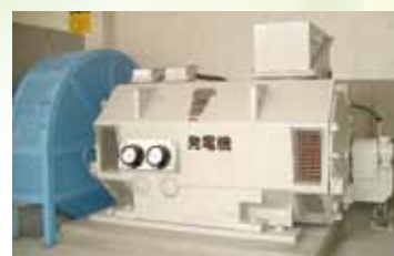
小水力発電所内部
