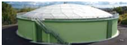
配水池(緊急遮断弁付き)
