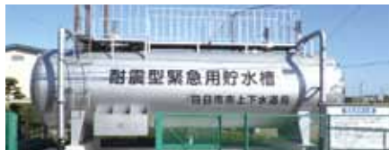
緊急用貯水槽(地上式)
