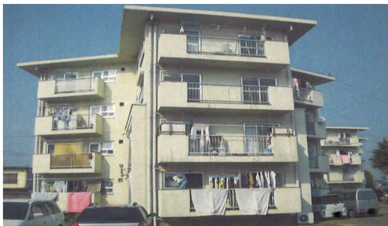
学生が入居予定の市営住宅の外観
