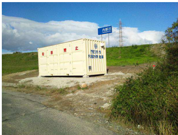
水防倉庫 (内堀:内部川)
