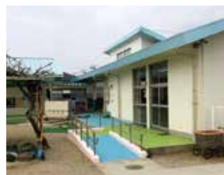
日永中央保育園改修工事
