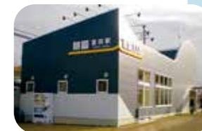
近鉄富田駅西口駅舎
