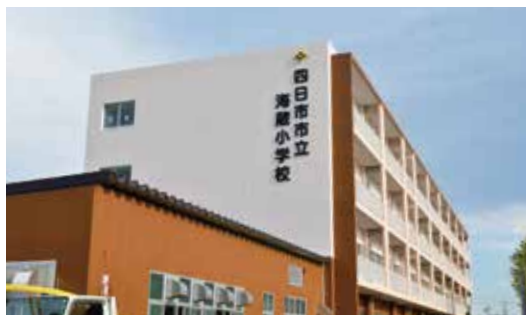
改修した海蔵小学校
