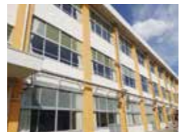
富洲原小学校 大規模改修工事
