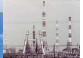
建設中の高煙突
