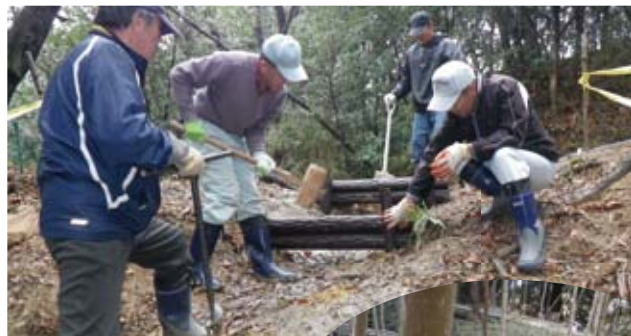
遊歩道の整備作業
