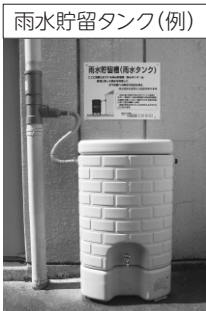
雨水貯留タンク(例)
