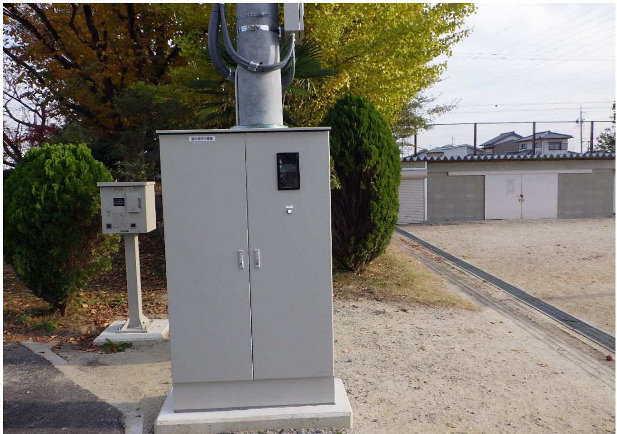
外観4(屋外照明分電盤、照明自動点灯盤)
