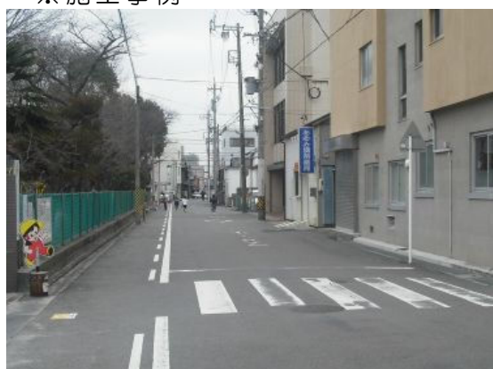
路面表示（施工前）
