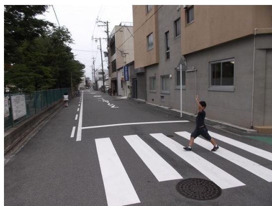
路面表示（施工後）
