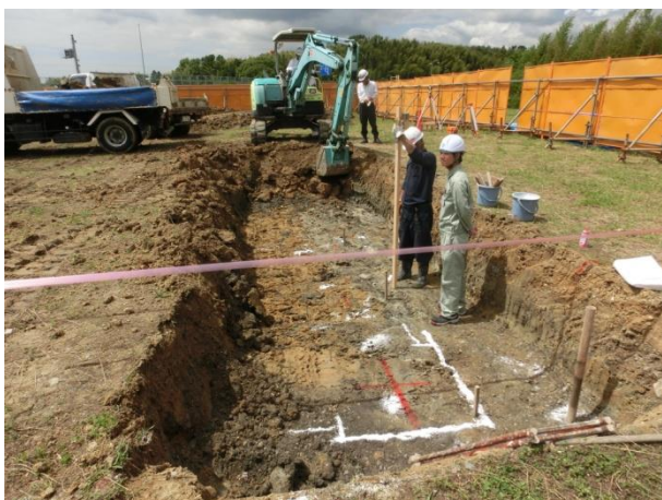
6月14日 基礎掘削
