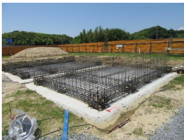
6月27日 基礎配筋
