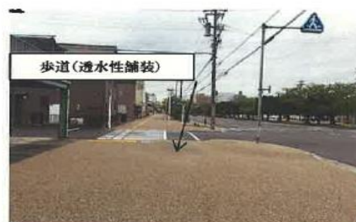
市道金場新正線の歩道舗装
