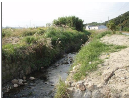
工事着手前 (流下能力 1.2 \text{ m}^3/\text{s} )
