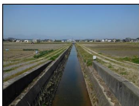
工事着手前 (流下能力 3 \text{ m}^3/\text{s} )
