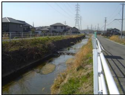
工事着手前 (流下能力 2.4 \text{ m}^3/\text{s} )
