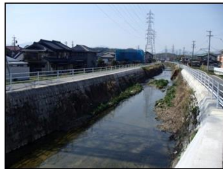
工事完成后 (流下能力 4.6 \text{ m}^3/\text{s} )
