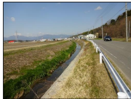
工事完成後（暫定） (流下能力 2.7 \text{ m}^3/\text{s} )
