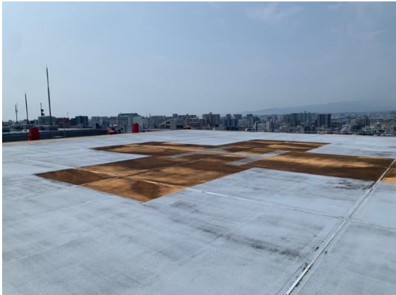
屋上ヘリポート
