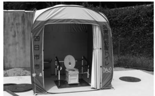
浄化槽の上に設置された災害時マンホールトイレ
