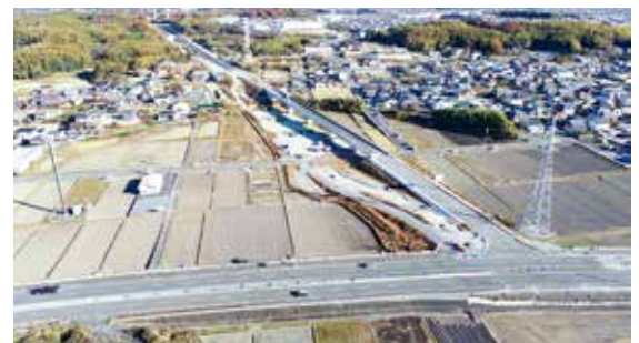
国道477号まで延伸した国道1号北勢バイパス
