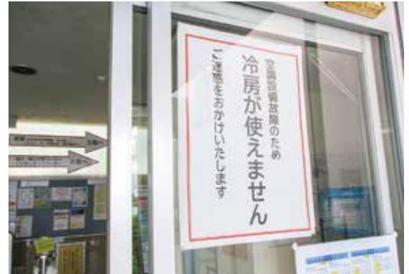
市立図書館の空調設備故障の張り紙
