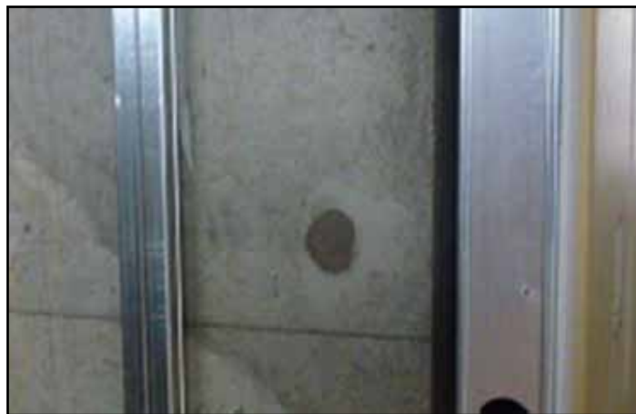
写真 3 : 木コン跡モルタル詰め状況
