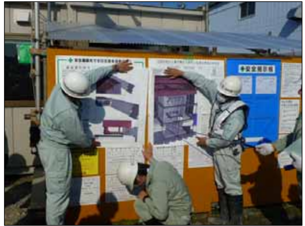
写真 2 : 3 D図による施工検討
