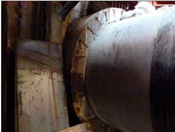
写真 3 : エントランス状況 (何れも漏水は認められない)
