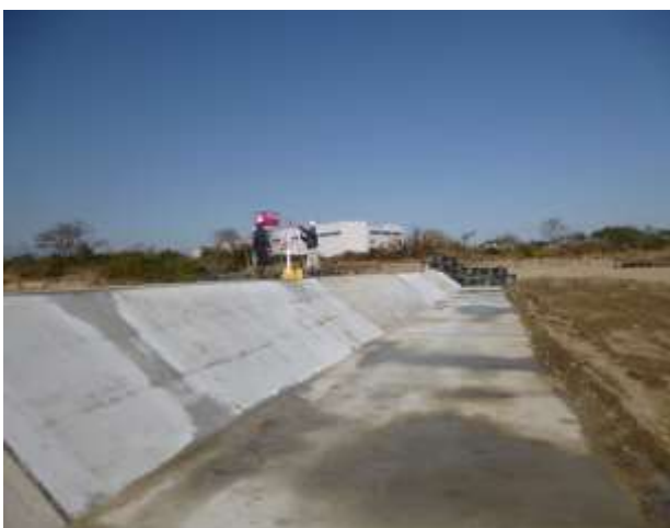
写真3：現場立会検測状況
