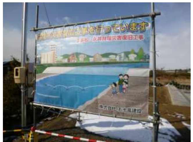
写真4：現場情報案内板掲示状況
