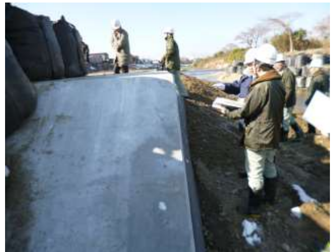
写真2：施工出来型 確認監査
