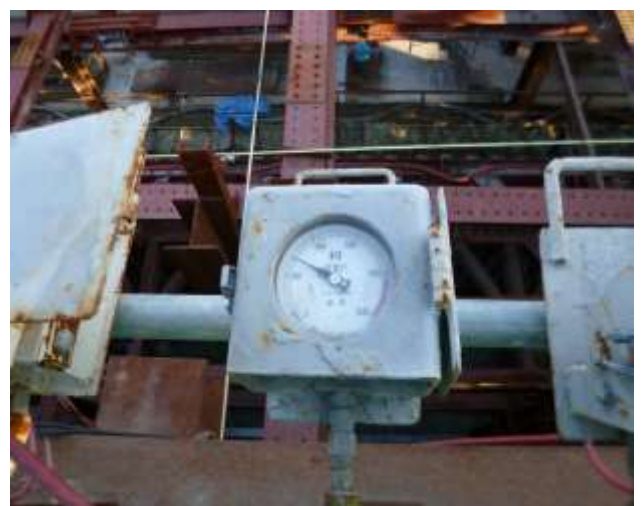
写真4：土留め応力計測装置
