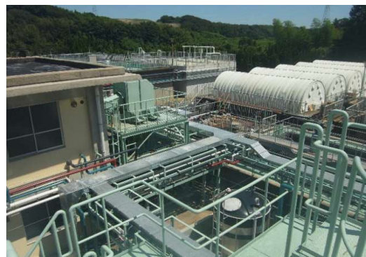
浸出水処理施設
