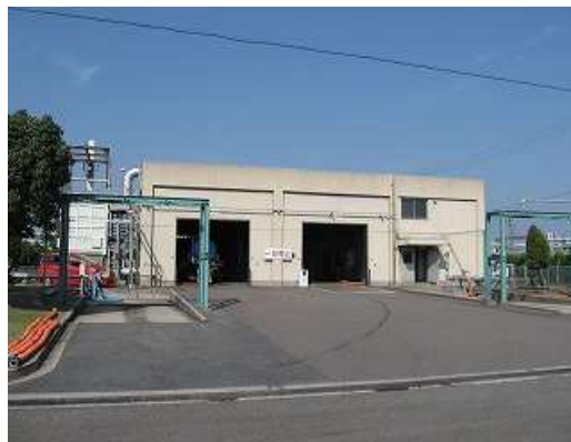
大井の川中継貯留槽
