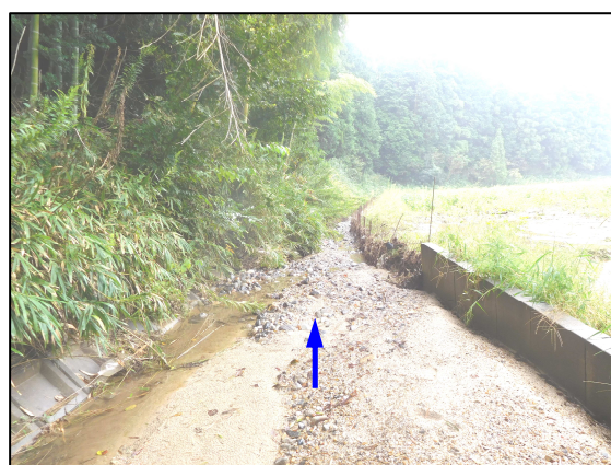
北小松町 排水路
