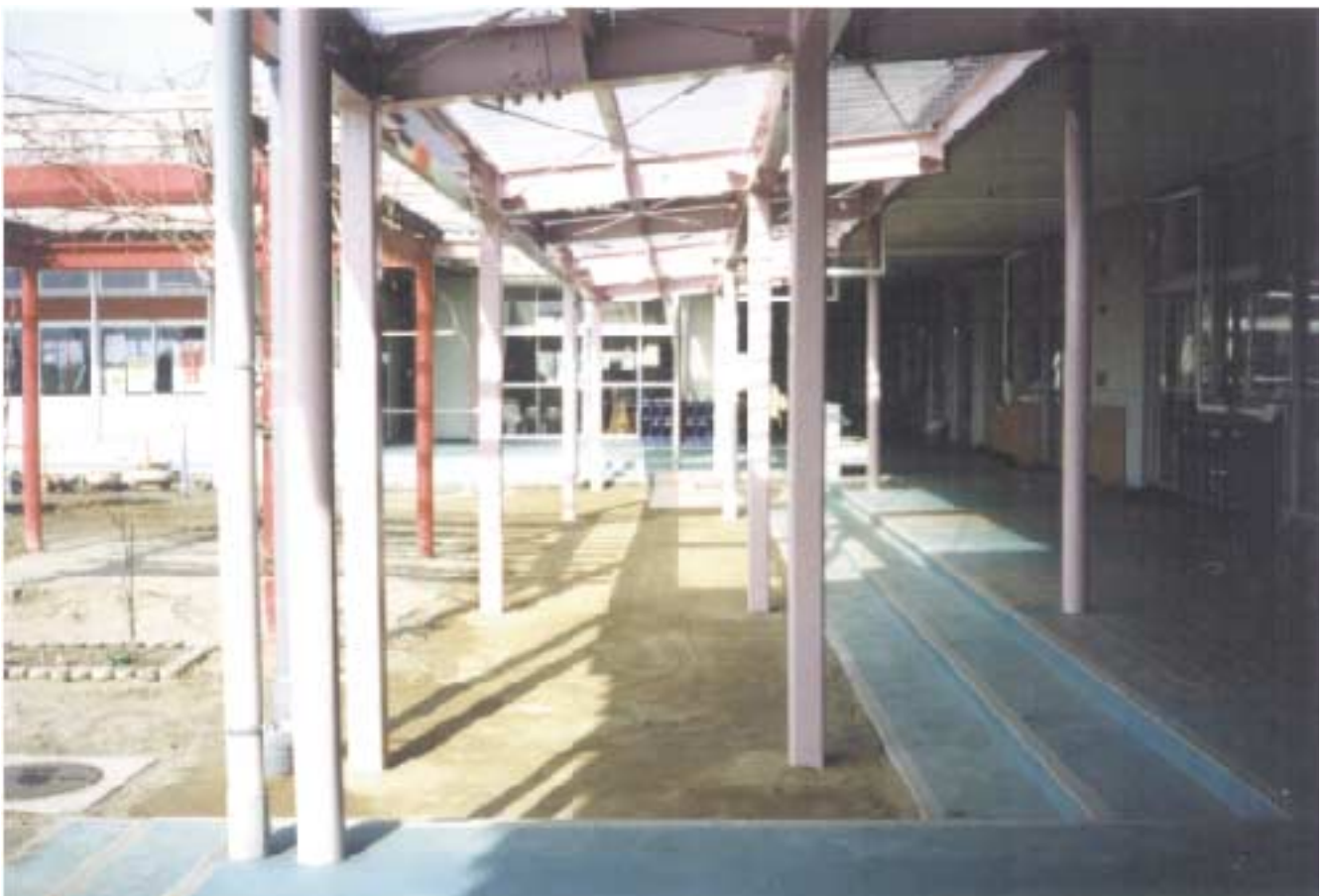
テラス増築部
