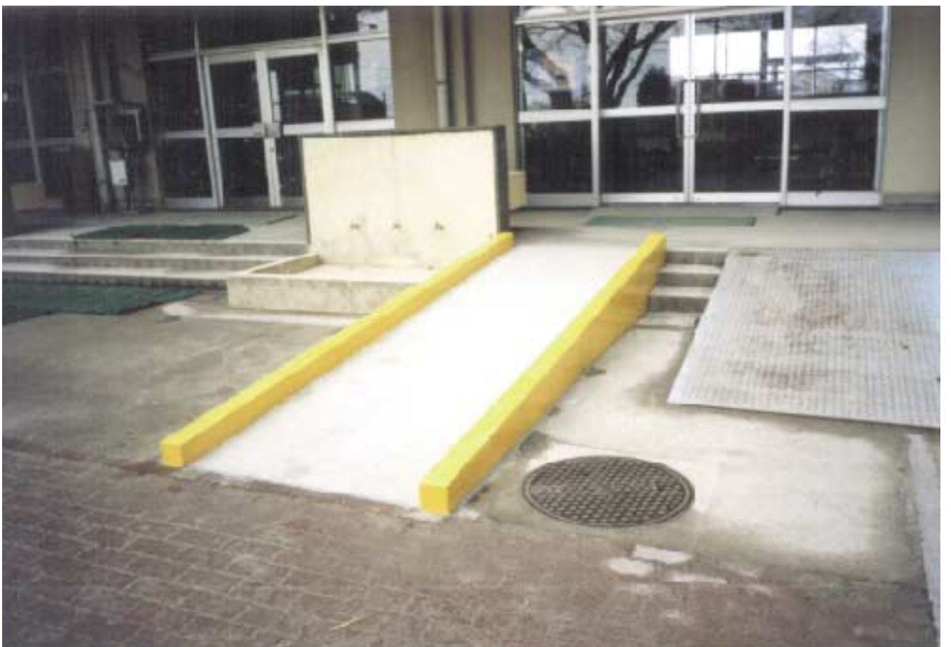
昇降口スロープ
