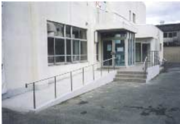
外部階段・アプローチ・スロープ
