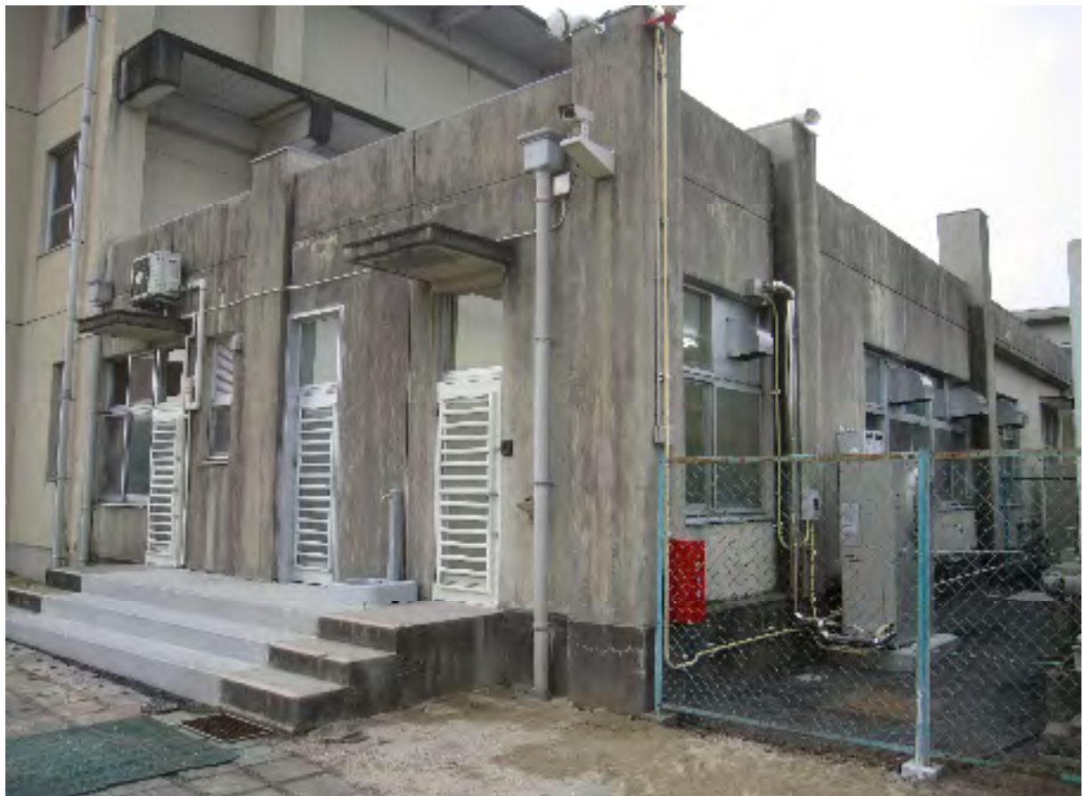
給食室外観(北西方向より)
