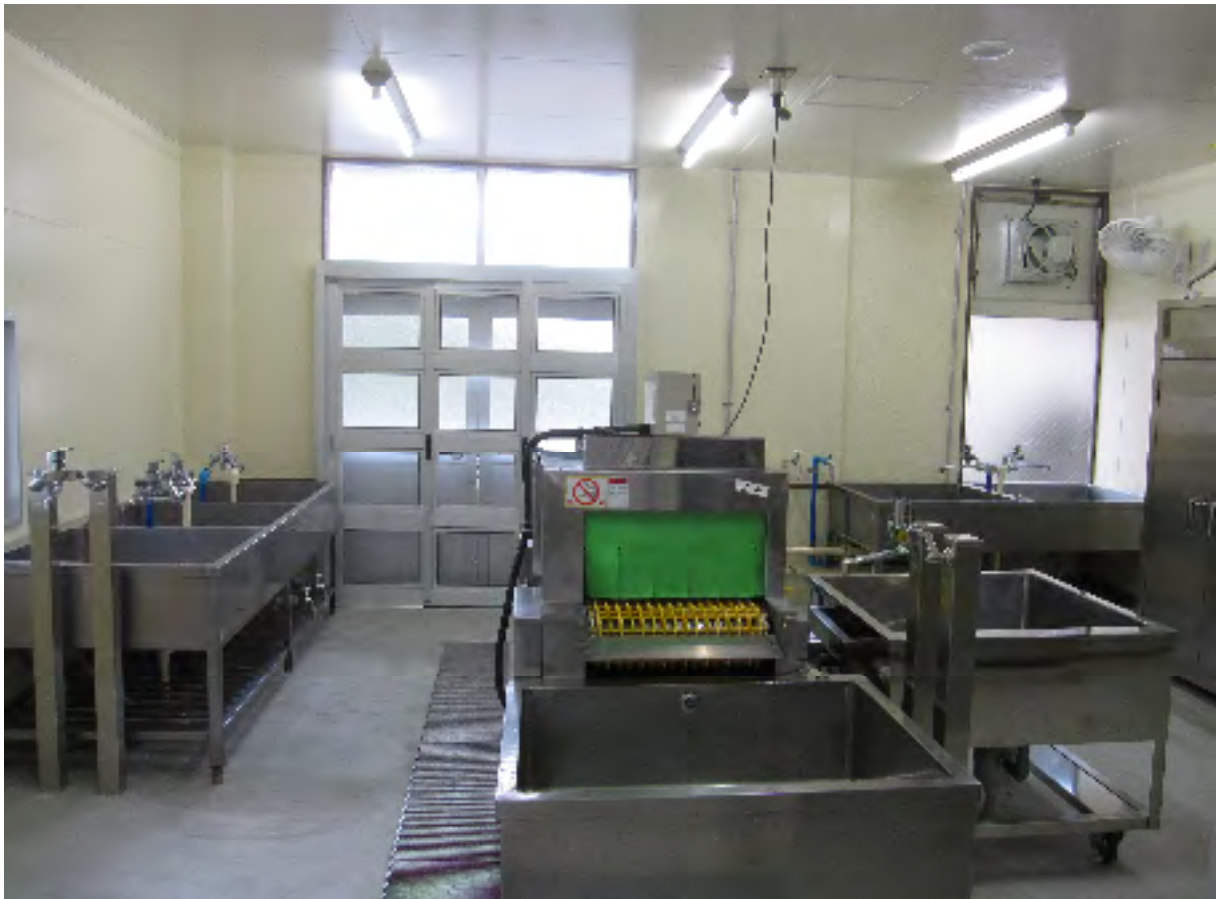
給食室内観(洗浄室)
