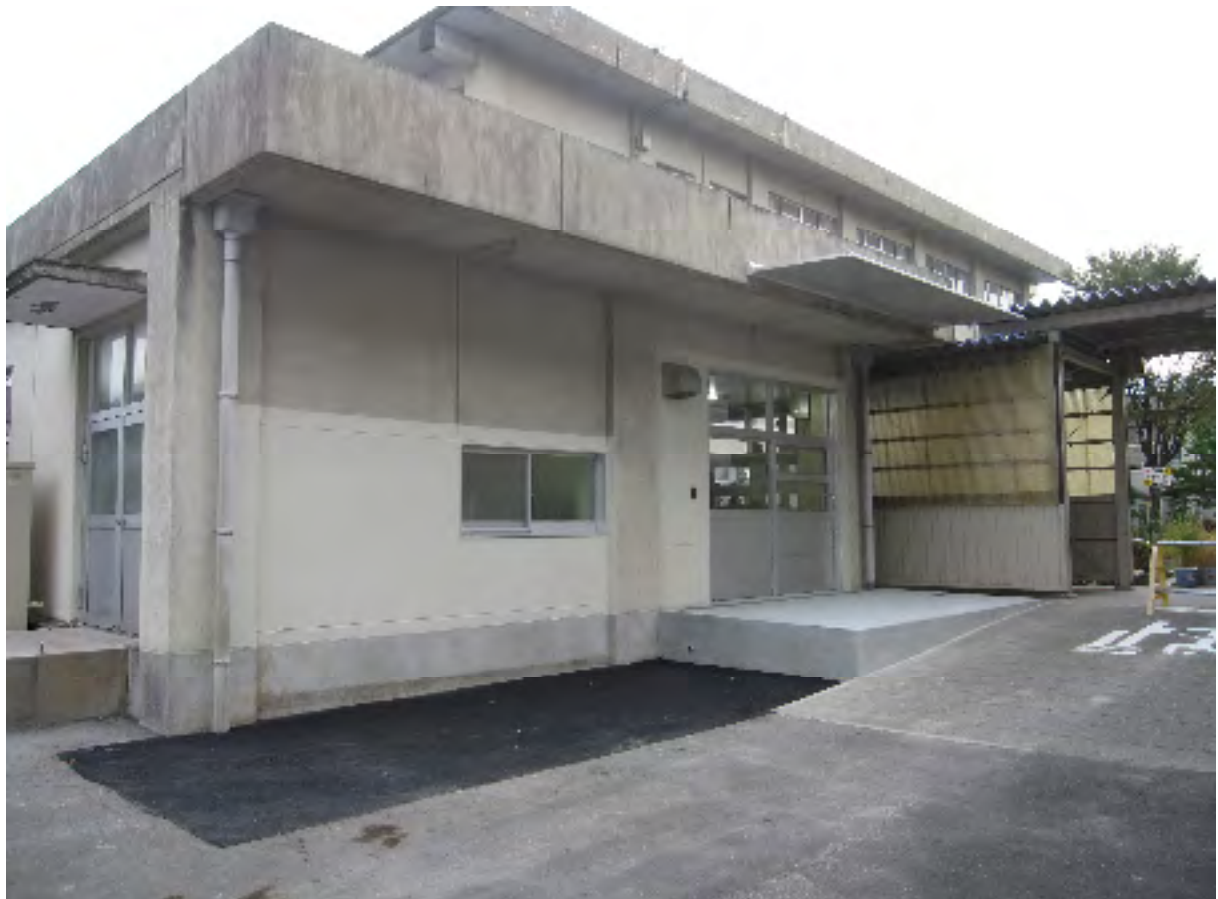
給食室外観(南西方向より)
