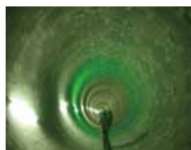
中央通り貯留管の内部
