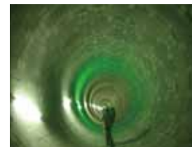
中央通り貯留管の内部
