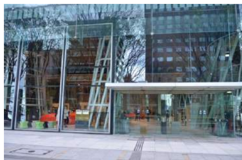
(1) 外部空間と一体的に活用できる設備の事例 (せんだいメディアテーク)
