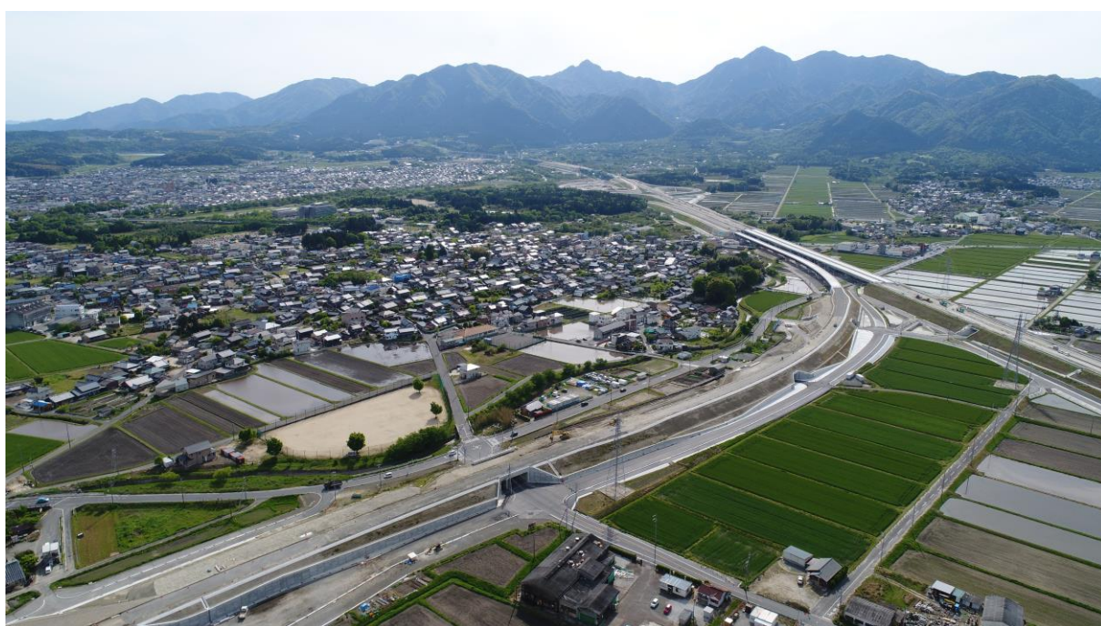
工事が進む四日市湯の山道路から新名神高速道路 菰野IC方面を望む
