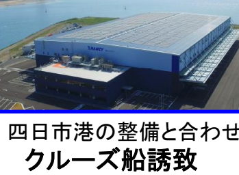
四日市港 新物流施設の整備(平成29年5月竣工)
