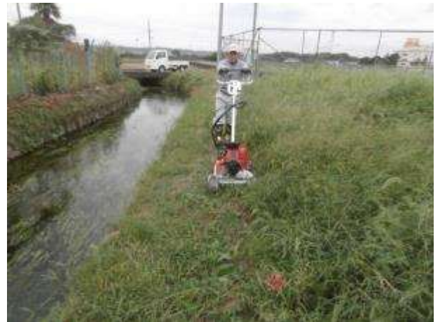
自走斜面草刈機を使用した智積養水の清掃作業
