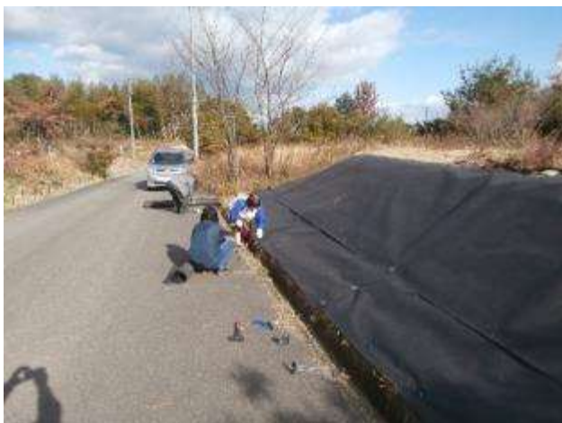
「のびっこ農園」の防草シート施工①
