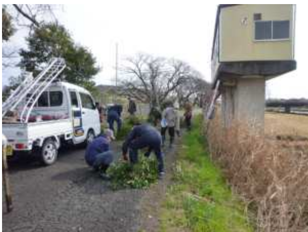
【桜】第30回「皆できれいに海蔵川の日」 海蔵川左岸：樹木剪定及び雑木除去
