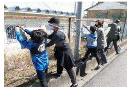
伊勢街道案内板設置作業
