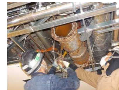
＜老朽化した配管・配線類＞
