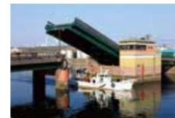
④臨港橋 船が通過する時だけ上がる跳ね上げ橋。
