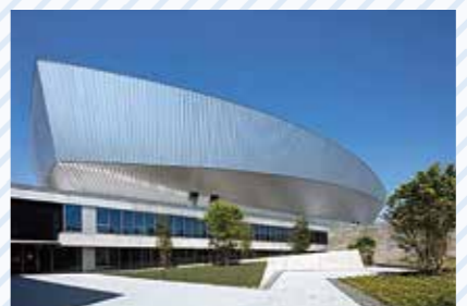
中央緑地運動施設整備事業(国体関連) (43億1,945万円) 三重とこわか国体・三重とこわか大会の開催に向けて、四日市市総合体育館などを整備しました。
