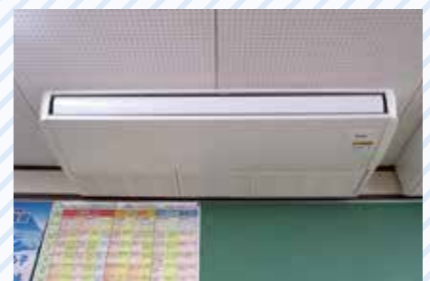
空調設備整備事業(小・中) (21億3,061万円) 小・中学校の普通教室の空調設備を整備しました。
