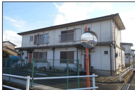
天白町市営住宅
