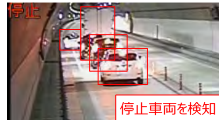
検知イメージ(トンネル内)
